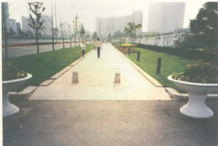
实例一 (全宽式单面坡缘石坡道)
