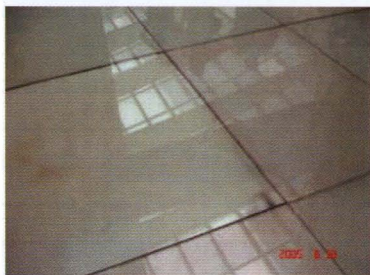
图3-1 框支承玻璃地板
