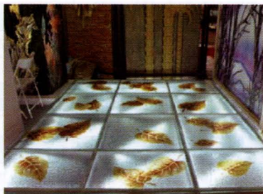
图3-3 框支承玻璃地板
