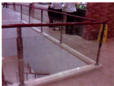
图1-4 室内玻璃栏板 框式安装
