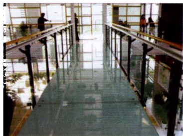
图3-4 点支承玻璃地板
