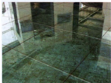
图3-2 框支承玻璃地板
