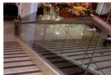
图1-7 承受水平荷载的 玻璃栏板
