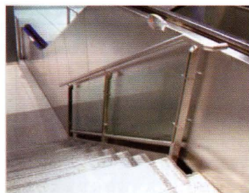
图1-3 室内玻璃栏板 框式安装
