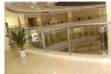
图1-6 室内玻璃栏板 点式安装
