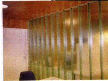
图2-4 U型玻璃隔断
