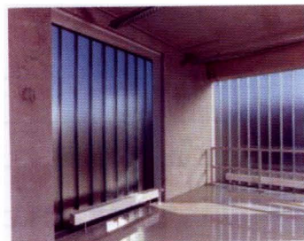
图2-3 U型玻璃隔断
