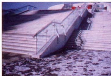
图1-1 室外玻璃栏板 点式安装
