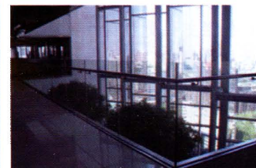
图1-8 承受水平荷载的 玻璃栏板
