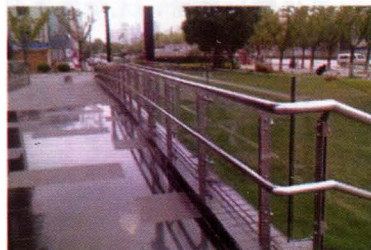
图1-2 室外玻璃栏板 点式安装
