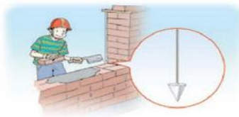
图 7.3-4 利用铅垂线确定竖直方向
